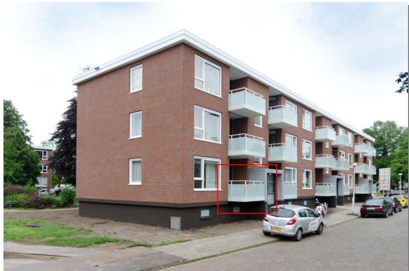
Figuur 1 Gereneveerde portiekflat. Het rood omcirkelde balkon zal beproeft worden
