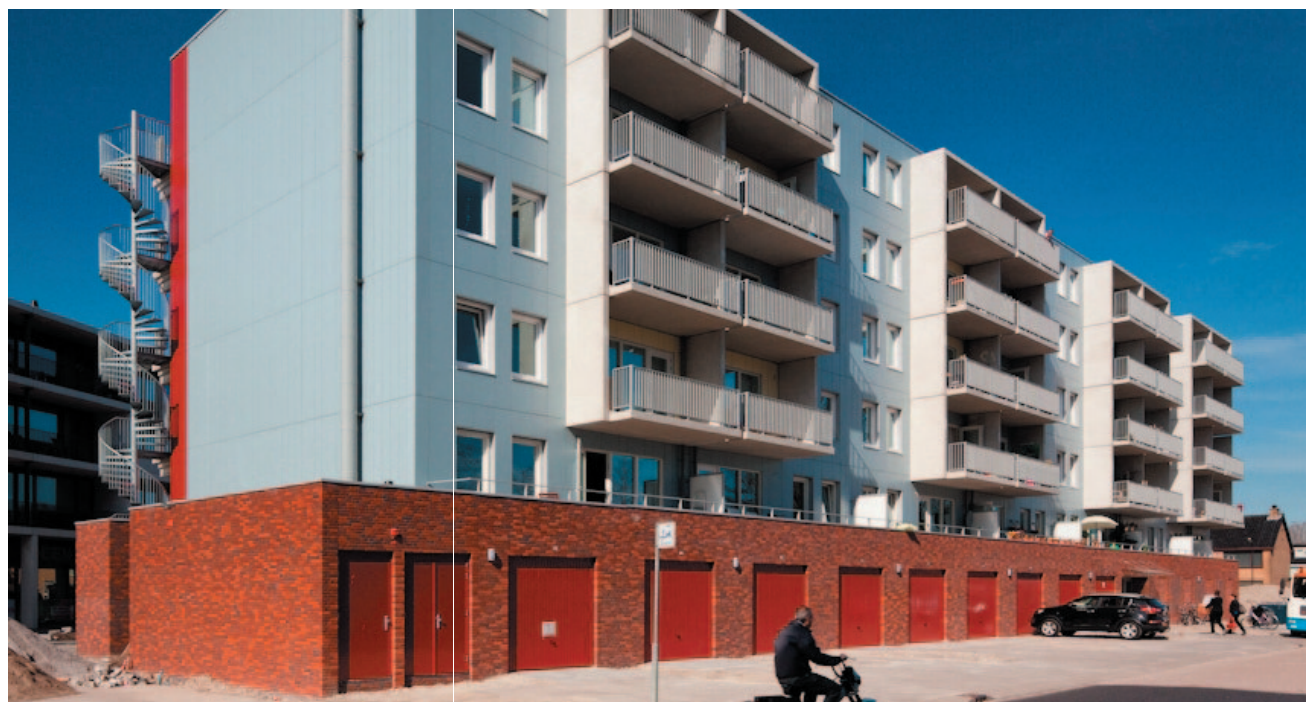
De balkonzijde van de Hortensiaflat. De prefab wandschijven zijn strak tegen het casco aangetrokken en verankerd.
