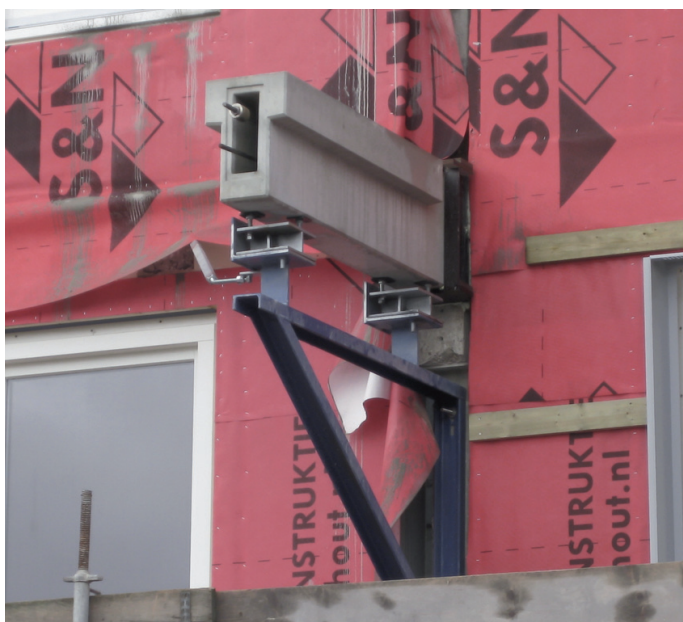
De T-vormige console – onderdeel van de Heli-verankeringstechniek van Norm-teq – zorgt voor een betere oplegging van de balkons.
